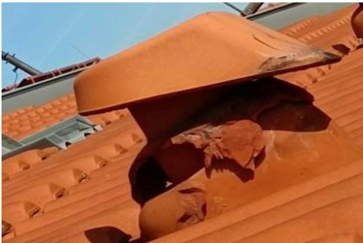
F37 Rozpadlý komínek odvětrání
