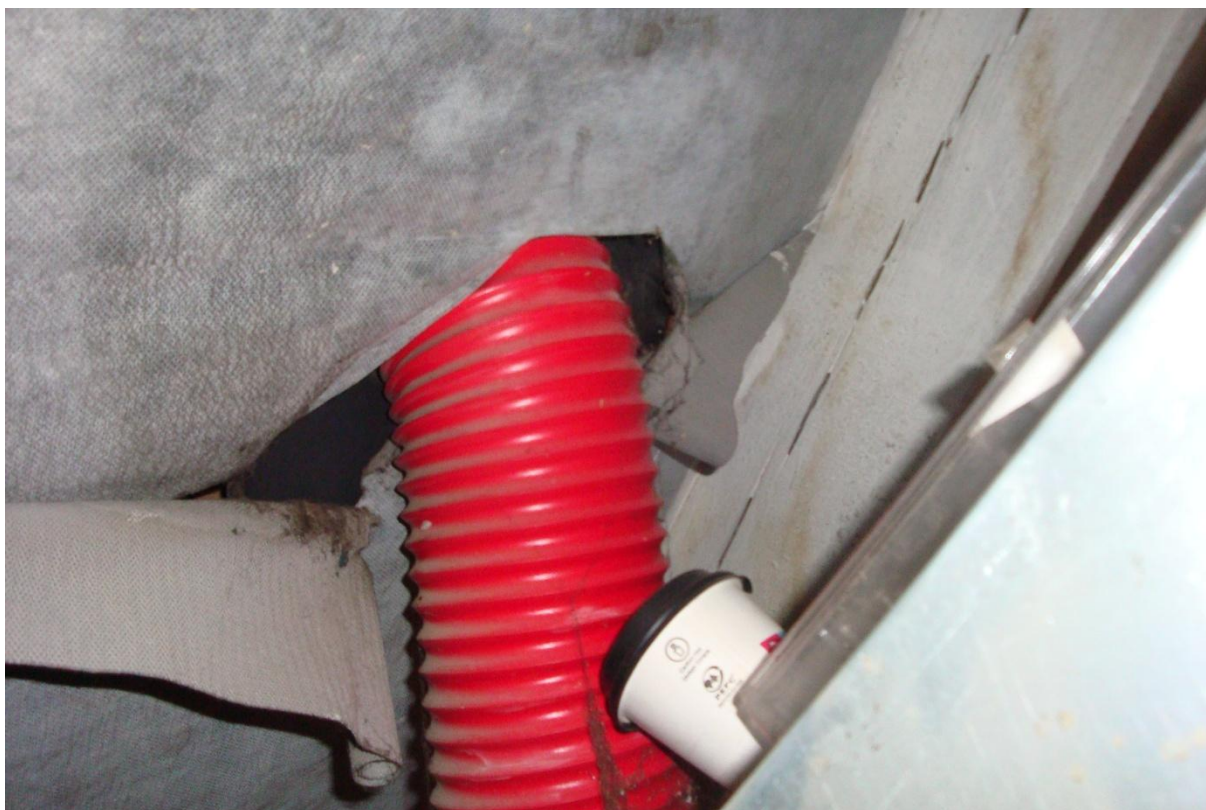
F15 Prostup pouze protržením fólie – bez komentáře
