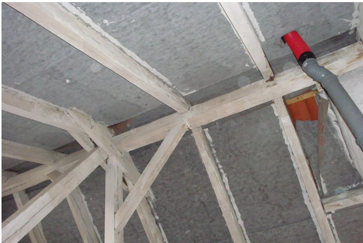
F2 Pohled z půdy na krov ve hřebeni
