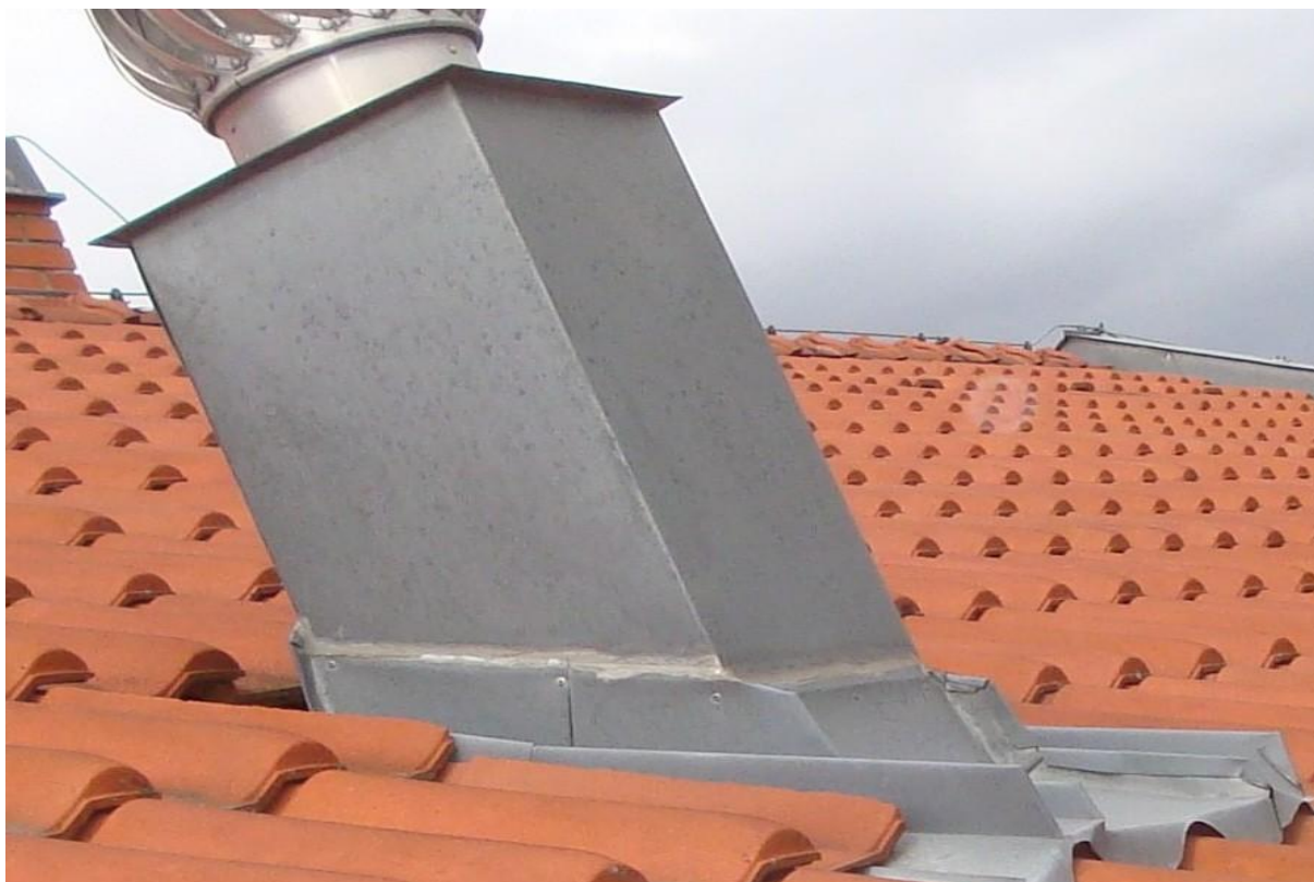
F33 Oplechování komínu s LOMANCEM – napojování a ohyby bez komentáře
