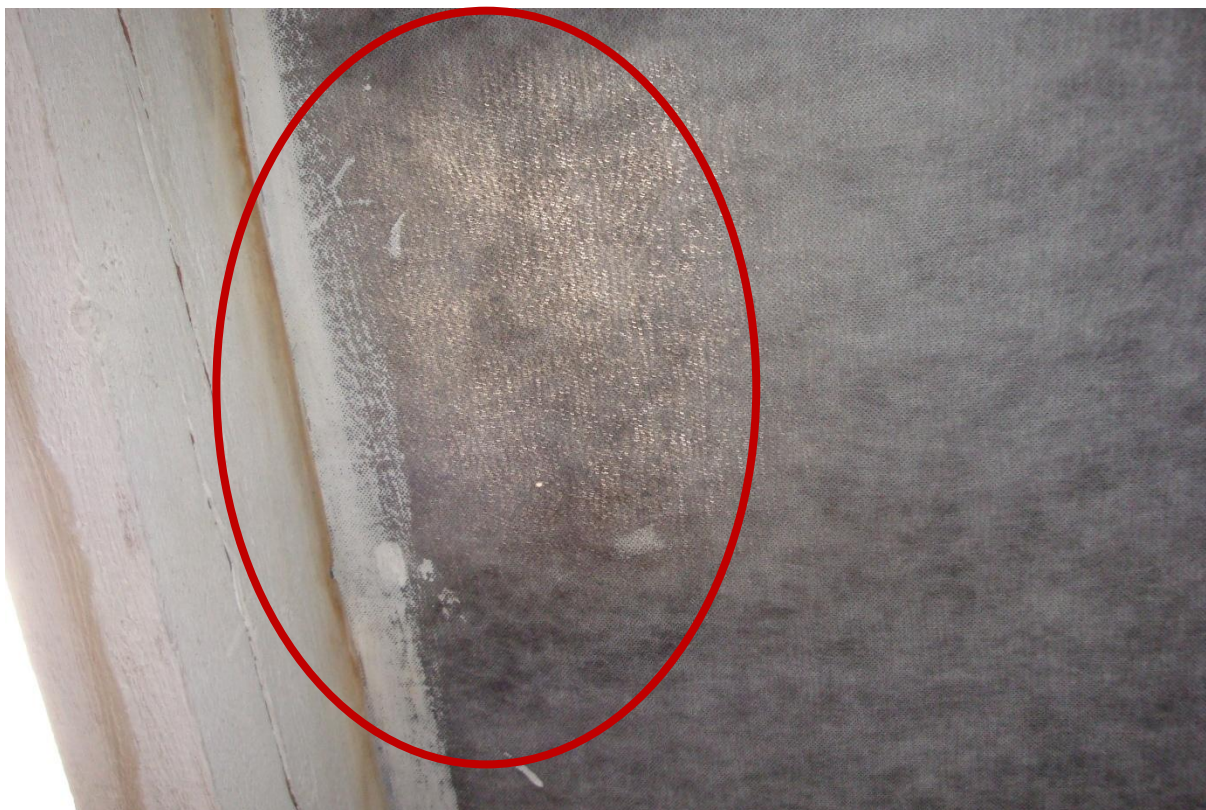
F35 Silně zdestruovaná fólie v ploše
