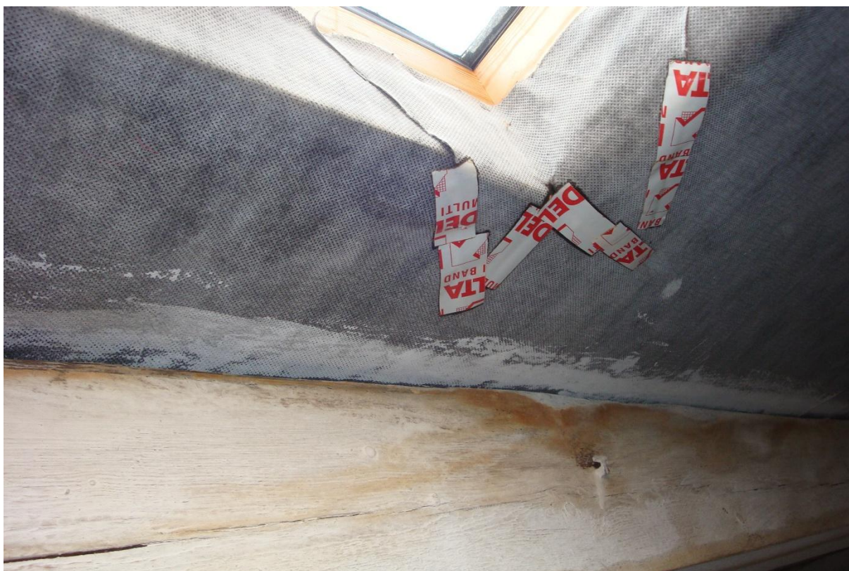
F4 Pokus o zalepení fólie proti stékající vodě
