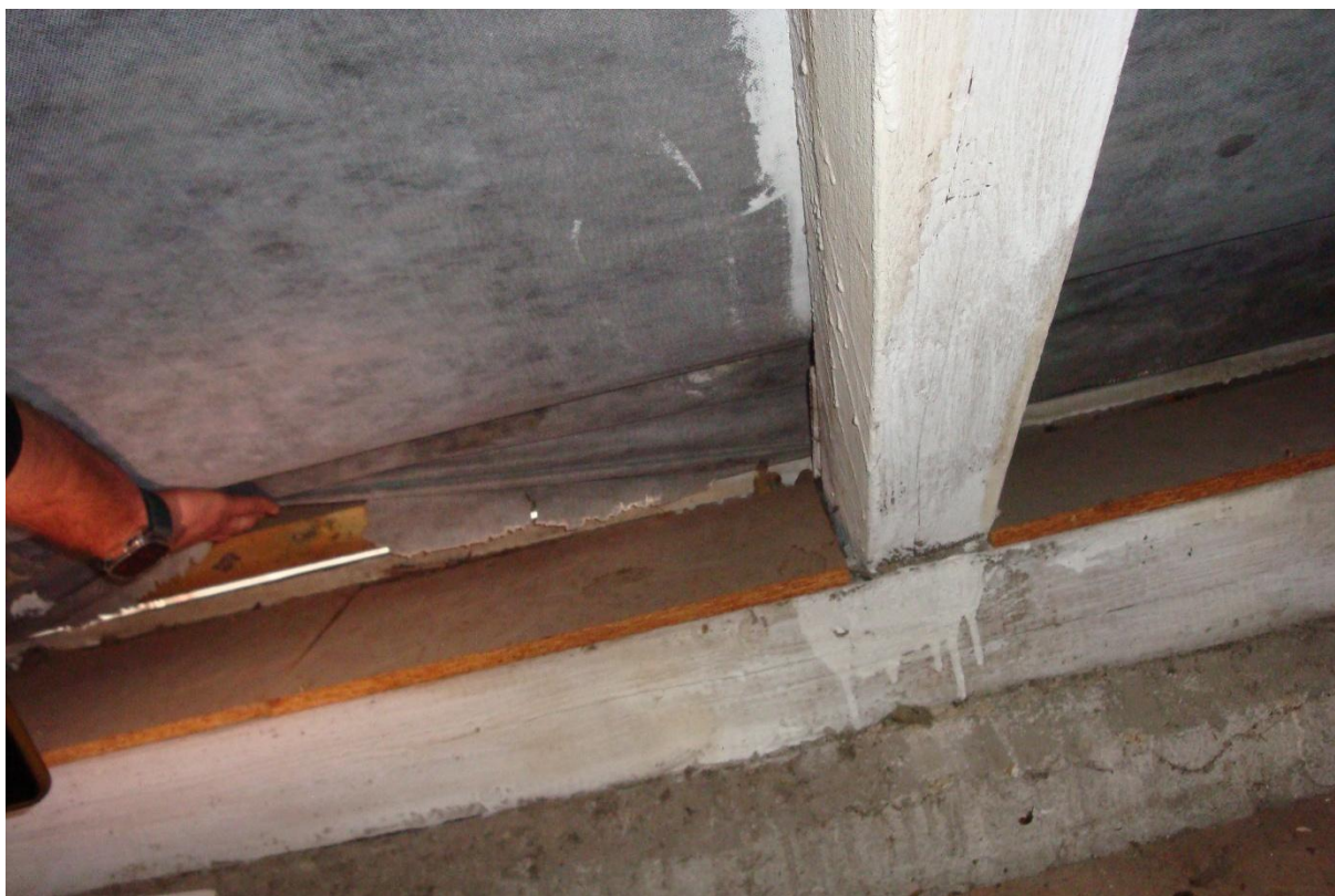
F11 V jiné části okap bez mřížky, rozpadlá fólie
