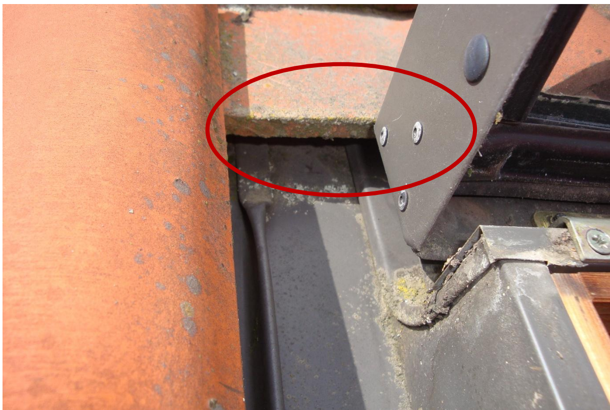
F27 Chybně dořezané tašky u výlezu , nelze otevřít
