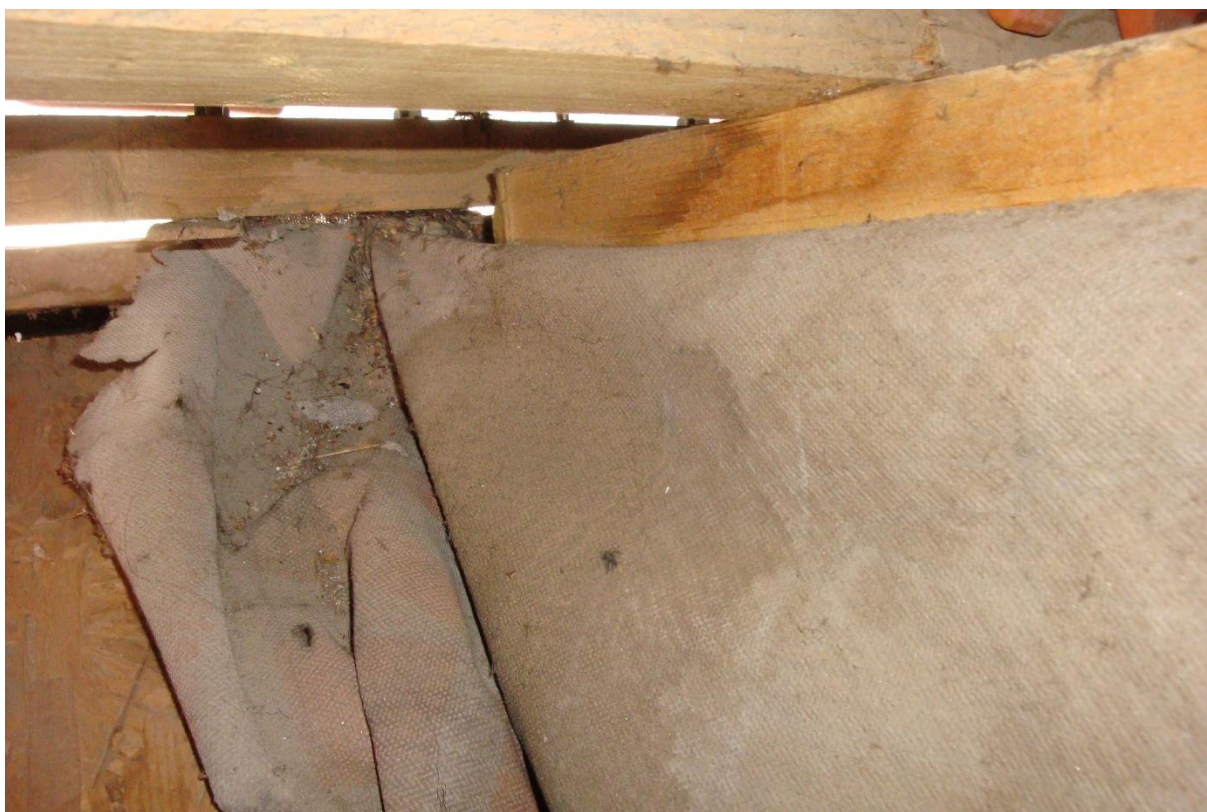
F8 Kontralať však končí v bednění nástřešního žlabu v okapní hraně
