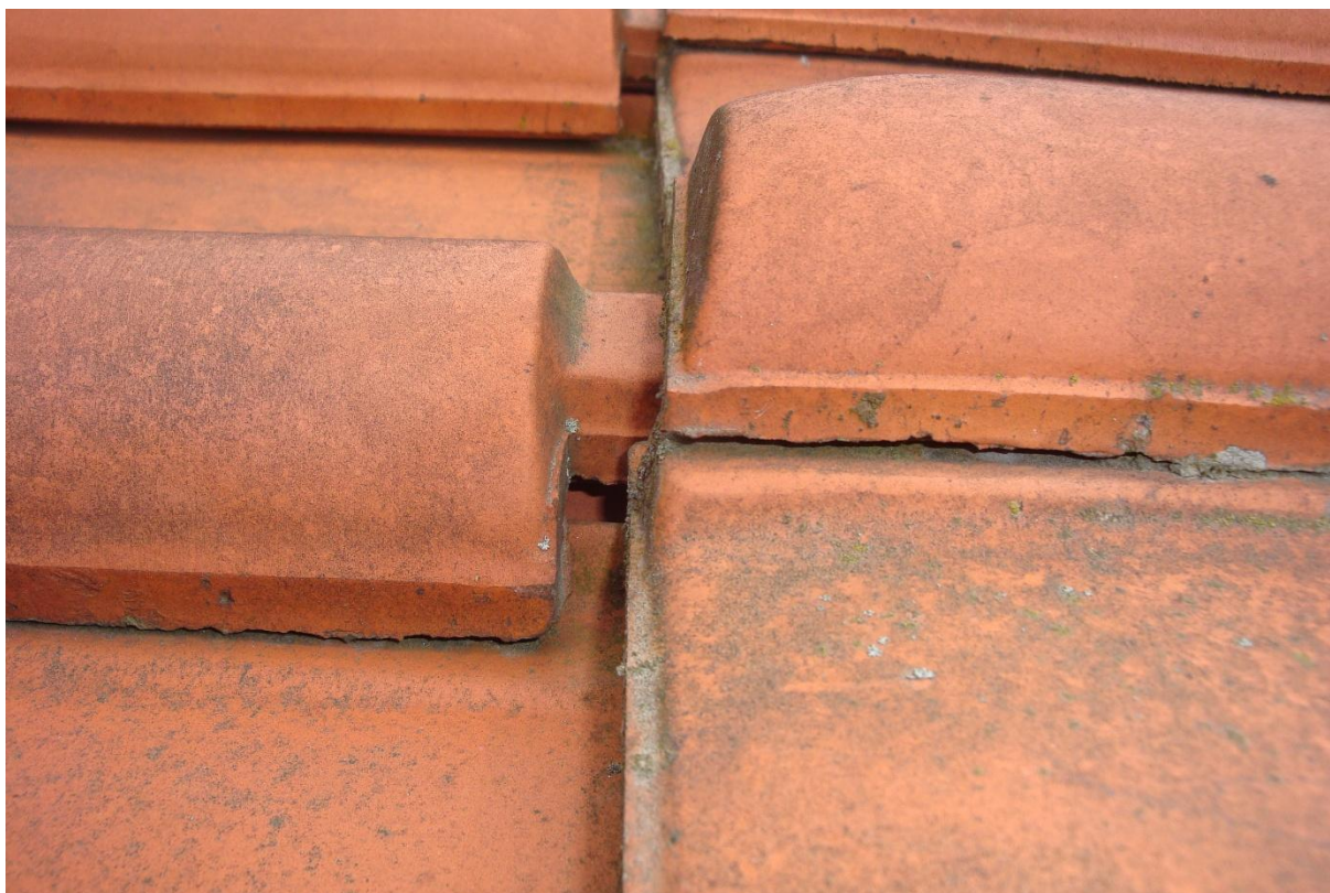
F25 Chybné rozlaťování, taška neseďí v zámcích
