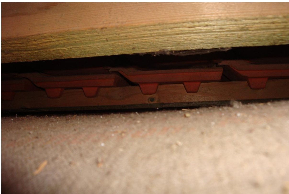
F10 Bohužel je pak stejně v další části střechy prostor kontratě ucpaný fólií
